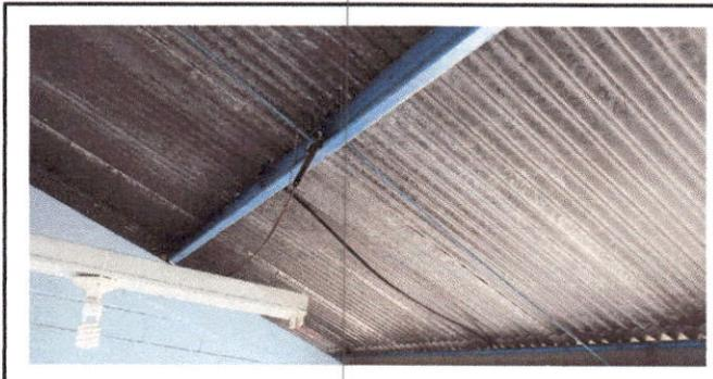
Foto 10: Sustrucción de ducto eléctrico + accesorios.
