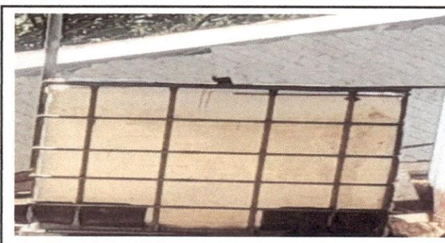
Foto 11: Sustrucción de depósito de agua 1100 lt.
